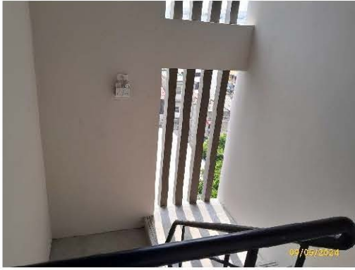
ระบบระบายอากาศของบันไดหนีไฟ (อาคารจอดรถ)
