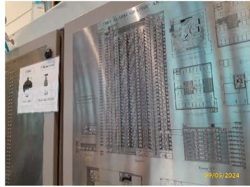
แผงควบคุมระบบสัญญาณแจ้งเหตุเพลิงไหม้
